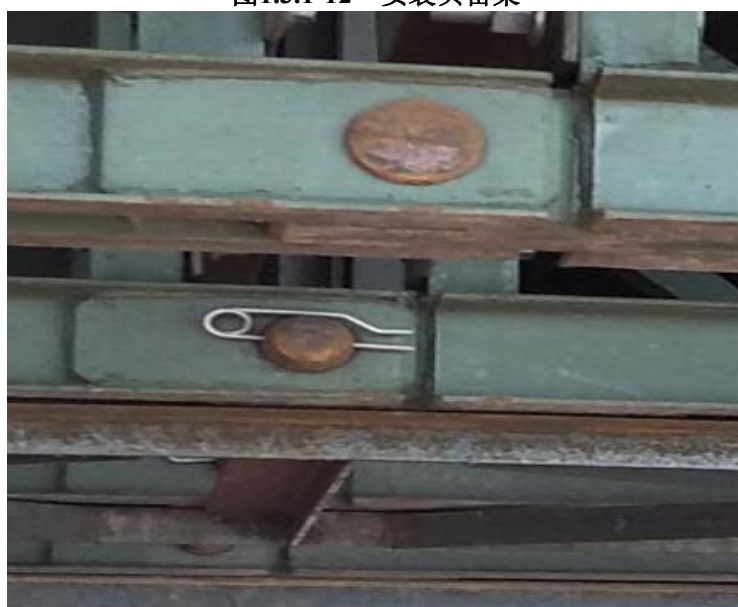
图1.3.1-13 贝雷用保险销将梢子锁死，防止松动脱落
