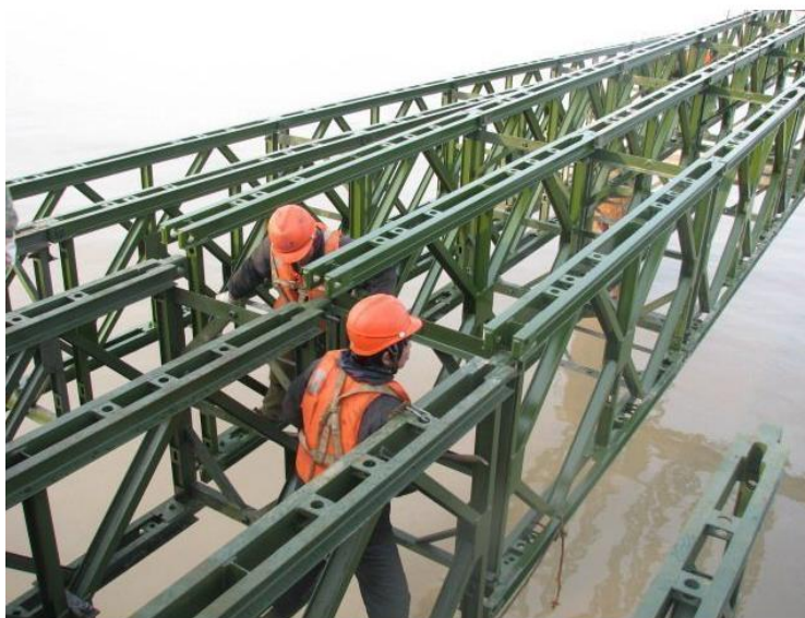
图1.3.1-12 安装贝雷梁
