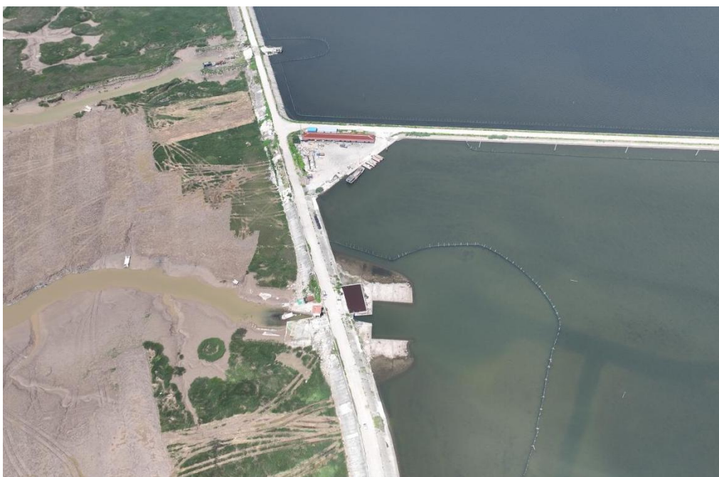
图 1-5 生态养殖区（III）养殖排水口现状图
